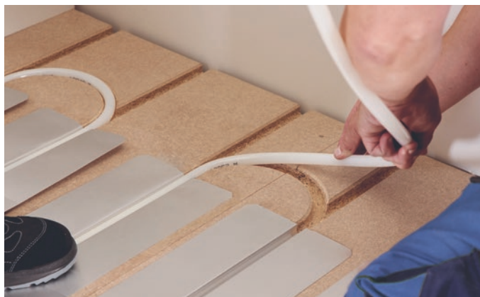
Figur 10 Montering av värmeslangar.
