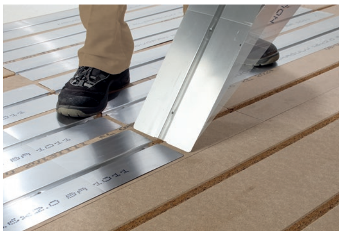
Figur 9 Värmefördelningsplattorna kan monteras/läggas stående.
